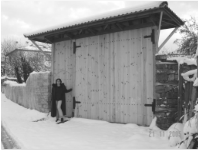
Портата е с размери 5 м. дължина и 4 м. височина; височина на едното крило е 3.30 м., а широчината му 1.68 м.
