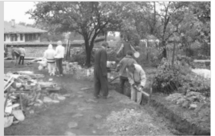
Прекара се ВиК инсталация - чист и мръсен канал.
