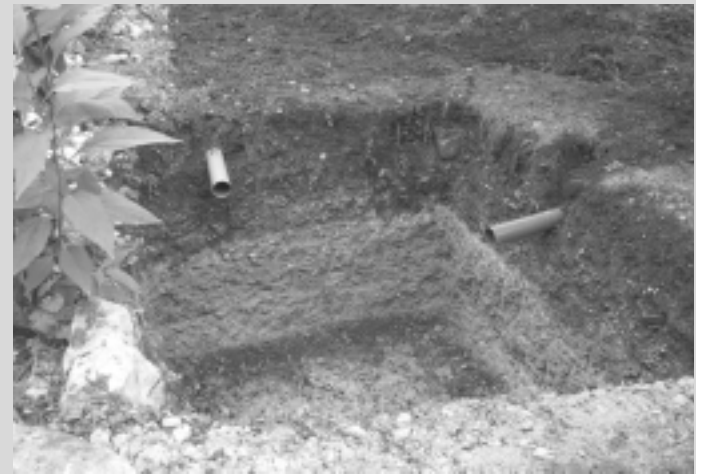
В село Арбанаси няма канализация и се изкопа септична яма с размери 2.60м на 2.10м и дълбочина - 1.85м. От средата на дълбочината теренът е скала.
